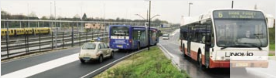
Busbaan in Nijmegen: asfalt geluidsarm en uiteindelijk niet duurder.
